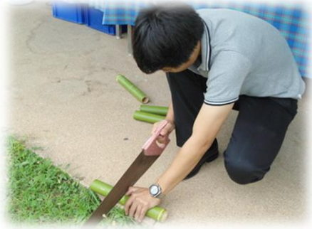
ตัดกระบอกไม้ไผ่จำนวน 3 ท่อน ยาวท่อนละ 15 ซม. โดยให้ด้านบนเปิด ด้านล่างปิด
