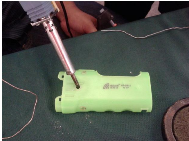
ภาพที่ 7 การเจาะรูเพื่อที่จะยึดแผงโซลาร์เซลล์ให้ติดกับตัวไฟฉาย
