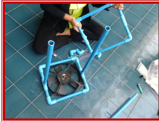
ภาพที่ 7 การติดพัดลมดูดอากาศ
